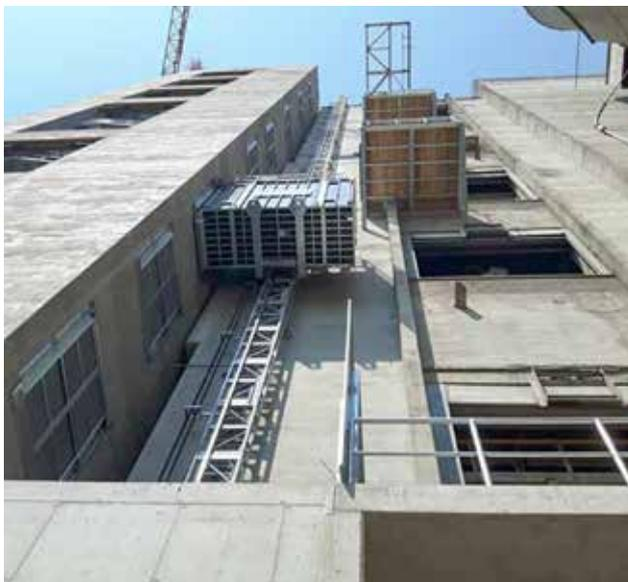
Die TÜV AUSTRIA Aufzugstechnik erhielt beim Zementwerk Hatschek in Gmunden den Auftrag zur Vor- und Abnahmeprüfung des ersten Zahnstangenaufzuges nach ASV 2015 und ÖNORM EN 81-20 in Österreich. Es handelt sich hierbei um einen baumustergeprüften Aufzug der Firma GEDA aus Deutschland. Der Aufzug fährt im Freien und hat eine Förderhöhe von 60,35 m. Die Anlage wurde durch die Modernisierung des bestehenden Zementwerkes zur Erhöhung der Energie- und Rohstoffeffizienz erforderlich. ■
