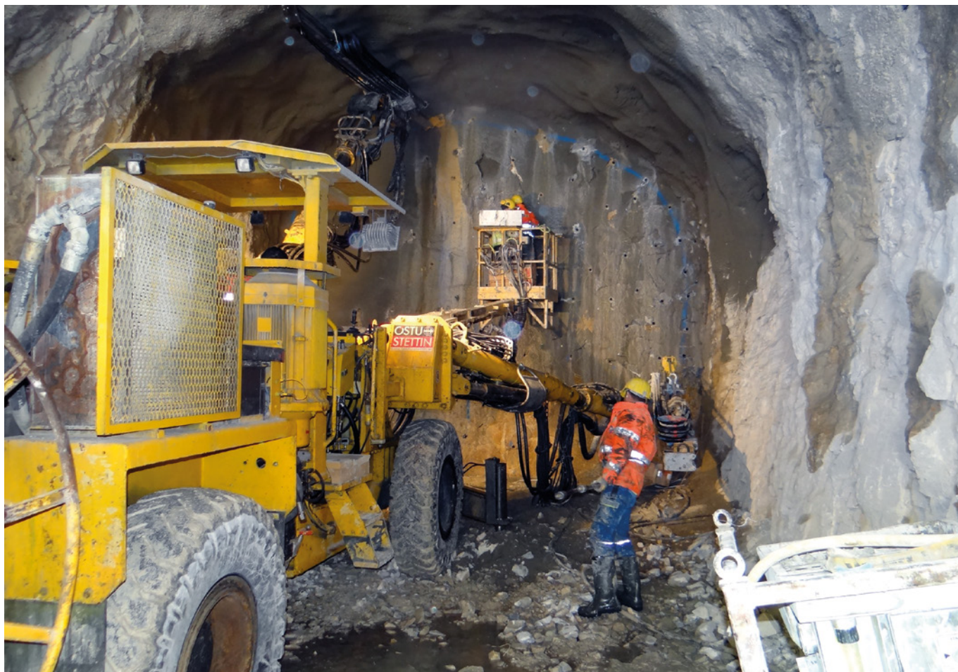
Der Klammersteinstollen wurde unter fachlicher Unterstützung von TÜV AUSTRIA weiter vorangetrieben. | The Klammerstein Tunnel was further excavated under expert guidance from TÜV AUSTRIA. Foto | Photo: TÜV AUSTRIA
